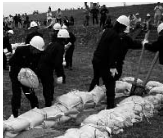
土のう積みを行う吉富町水防団
