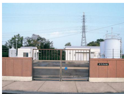
上水道幸子浄水場
