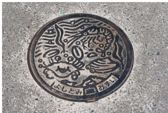
下水道マンホール
