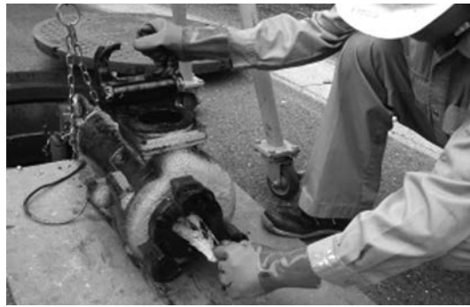
ポンプ内に異物が絡まっている！！
