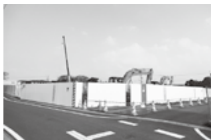
別府団地建設工事始まる。
