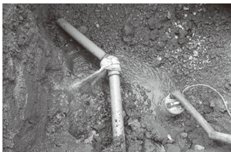
今年度の漏水調査で発見した漏水 (平成28年11月 広津上区)
