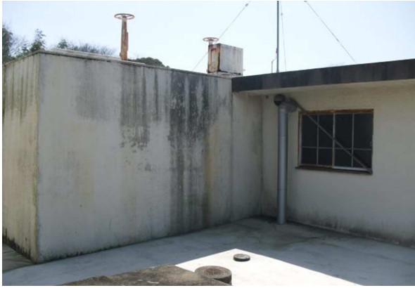
写真 3-1-1. 別府浄水場・第1配水池
