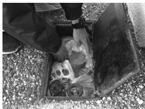
水道メーターボックス内にビニール袋に入れたタオルを詰めた状態
