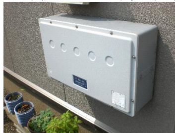
インバータ(又はパワーコンディショナー)写真
