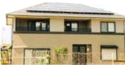
家屋 写真(設置箇所のわかるもの)
