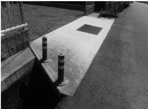
コンクリート床版
