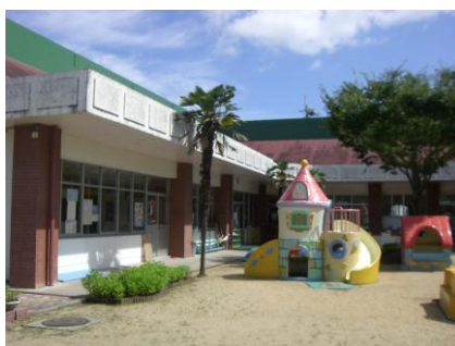
幼保一体化施設こどもの森 吉富幼稚園・吉富保育園
