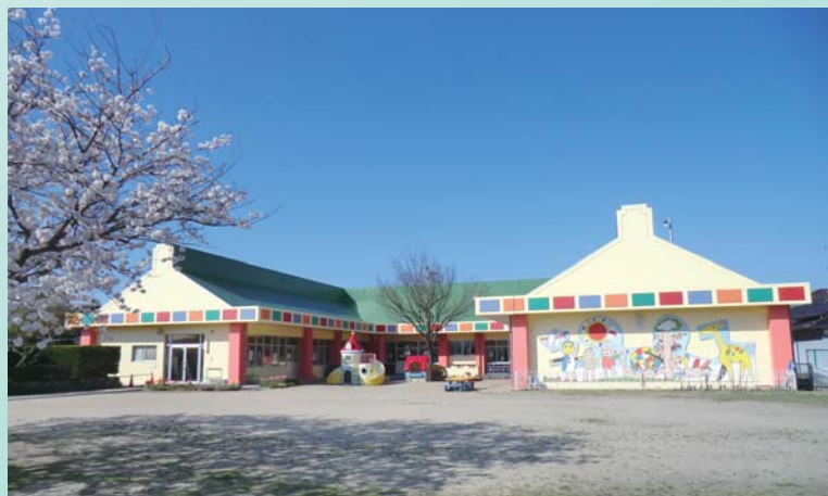
幼保一体化施設こどもの森は、外壁改修も終わり、こんなに美しく生まれ変わりました。
