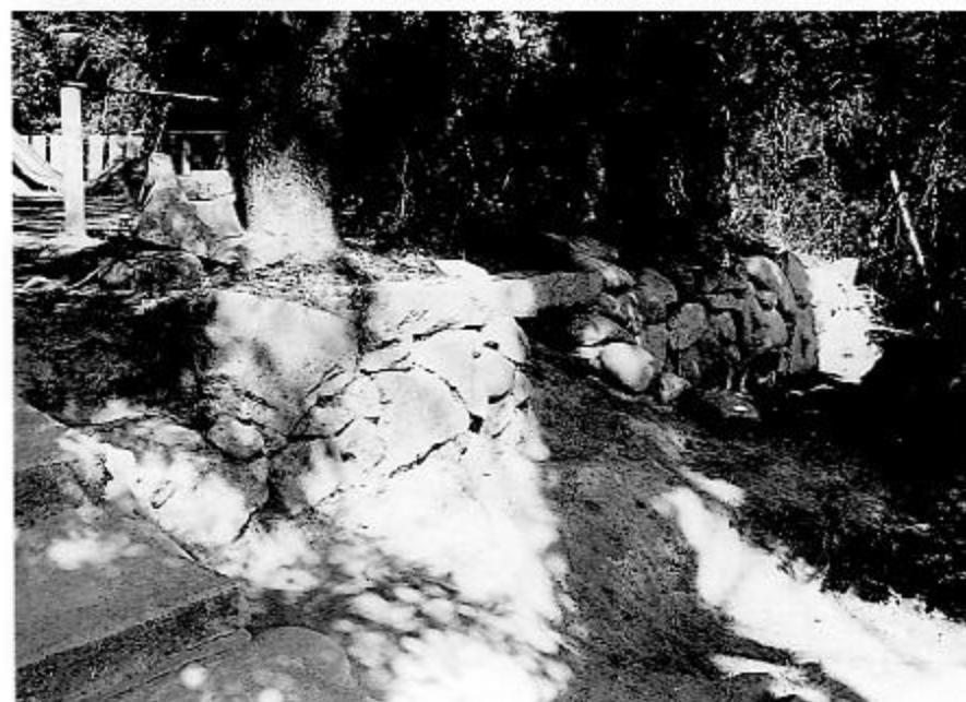
3. 石垣（南西から）
