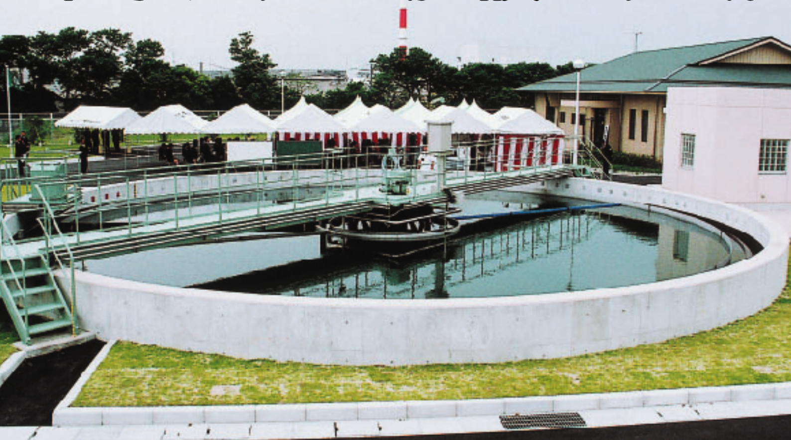
下水道終末処理場 吉富クリーンセンター（手前は最終沈澱池）
