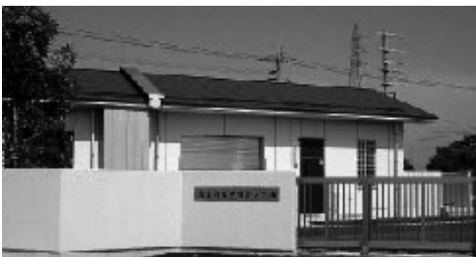
汚水中継ポンプ場
