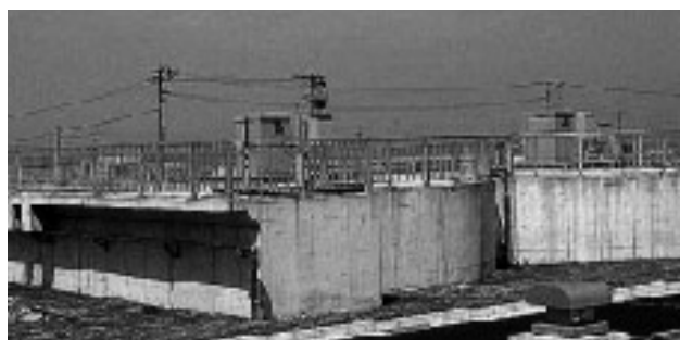
オキシデーションディッチ槽
