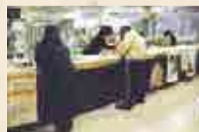
▲昭和58年頃の庁舎内の様子
