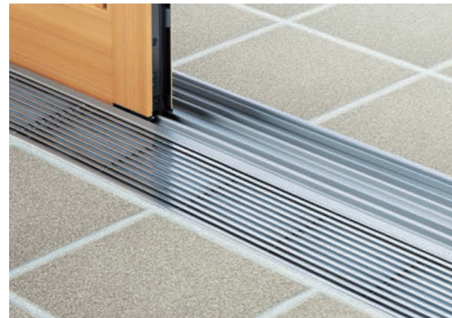
段差を設けない設計の例
