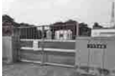
第2浄水場（幸子浄水場）
