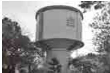
第3配水池（天仲寺公園内）
