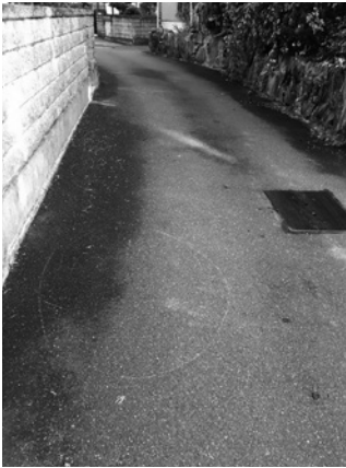
幸子上区内漏水箇所
