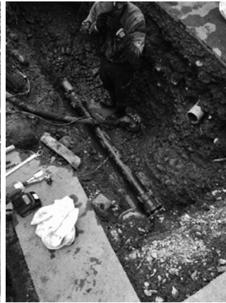
水道管の補修完了状況
