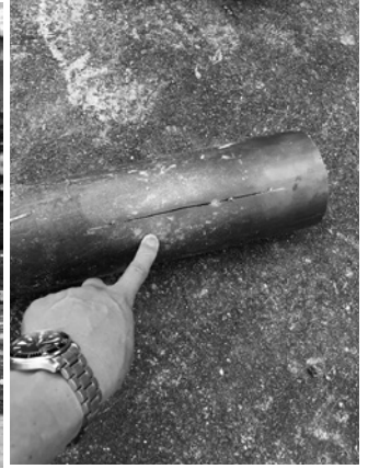
水道管漏水部位状況
