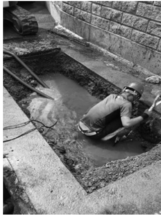
緊急工事状況
