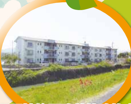
幸子団地住戸改善等改修事業
