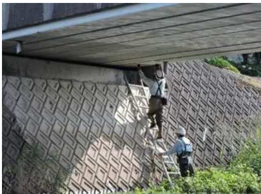
〔脚立による定期点検状況〕
