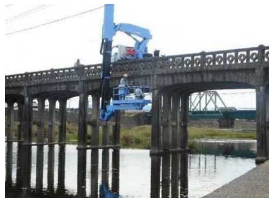
〔橋梁点検車による定期点検状況〕
