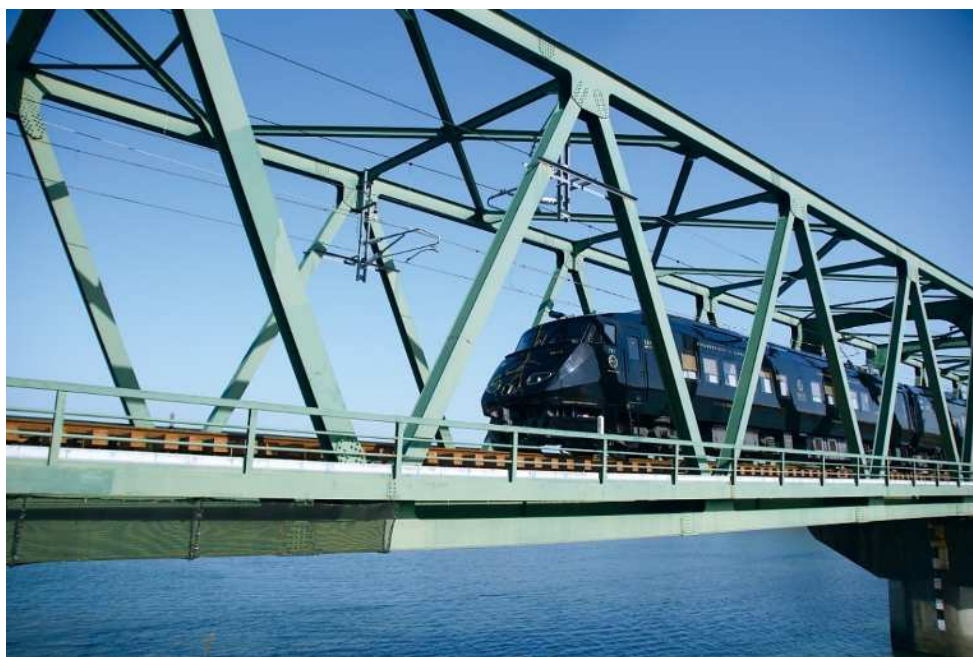
日豊本線 山国川橋梁
